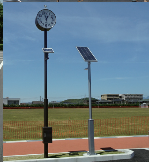
(中) 益城町辻地区 / (下) 菊陽町防災広場
