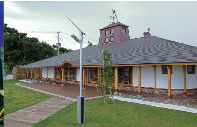
(上) 鹿児島県川内港／(中) 熊本県甲佐町
